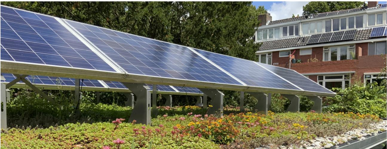
Abbildung 3: Dachbegrünung kombiniert mit aufgeständerter Photovoltaikanlage (Foto: René Notenbomer/stock.adobe.com)
