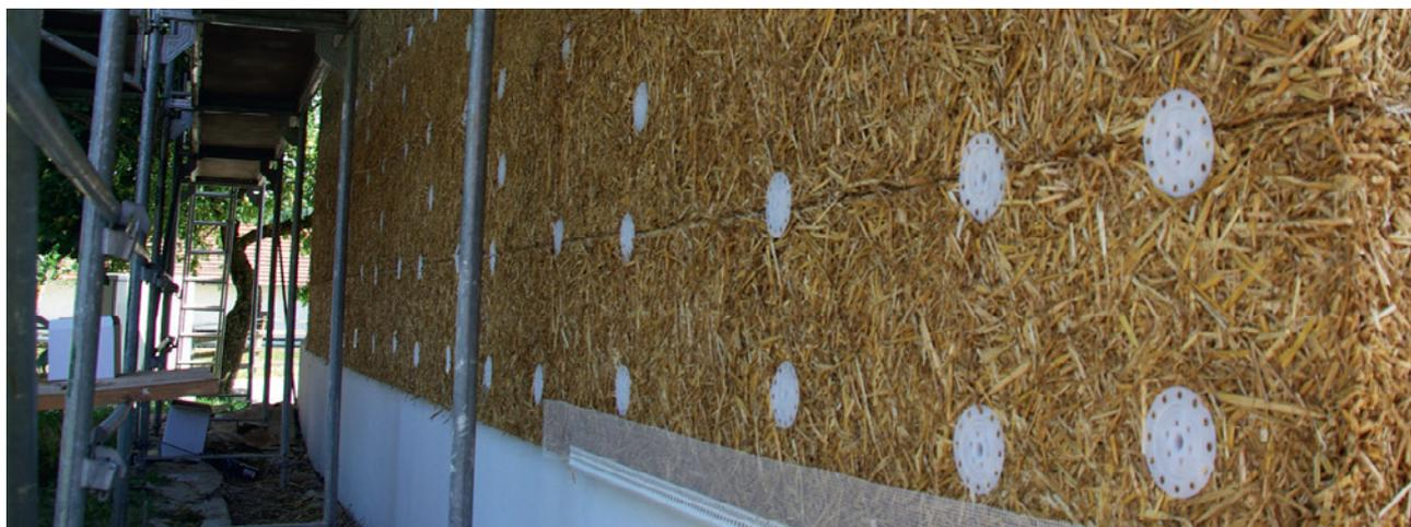
Abbildung 2: Gebäudedämmung mit Strohdämmplatten (Foto: maxit)
